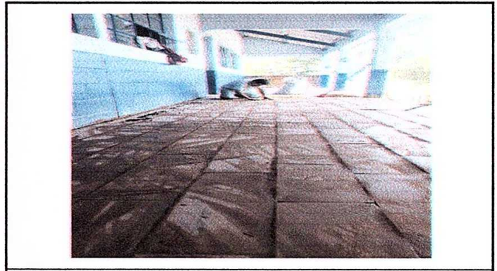
Foto2: Reparación de piso por piso granito
