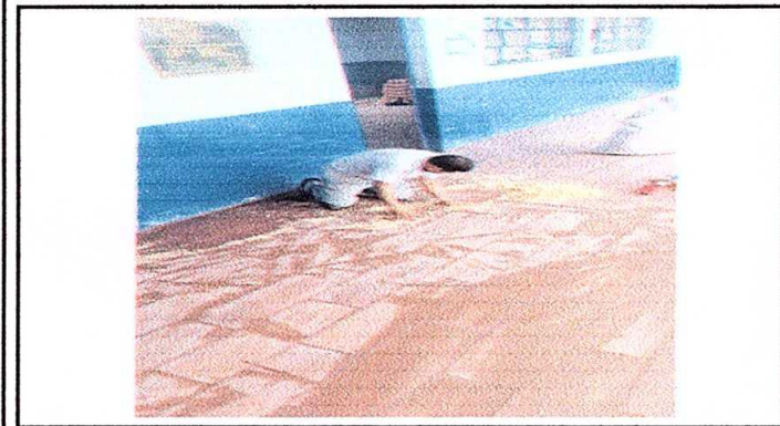
Foto 3: Reparación de piso por piso granito
