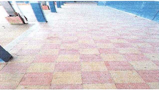
Foto 3: Reparación de piso por piso granito
