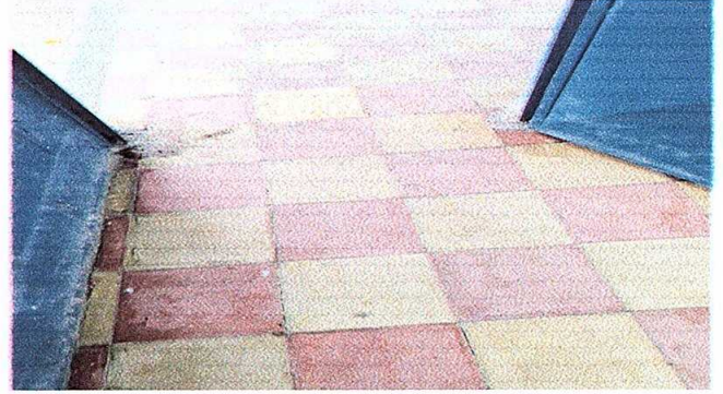
Foto2: Reparación de piso por piso granito
