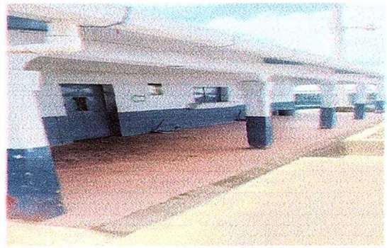
Foto 6: Reparación de piso por piso granito
