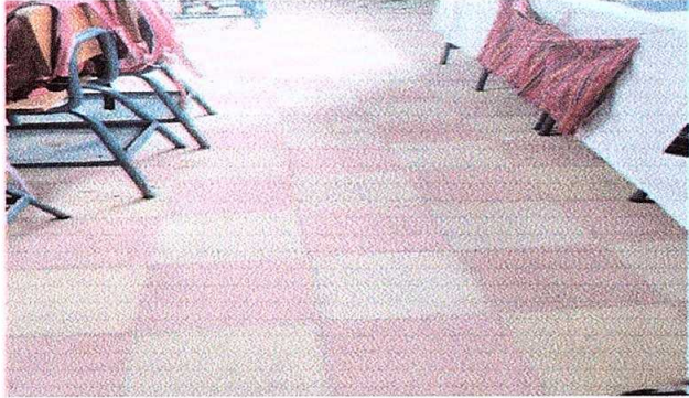
Foto1: Reparación de piso por piso granito
