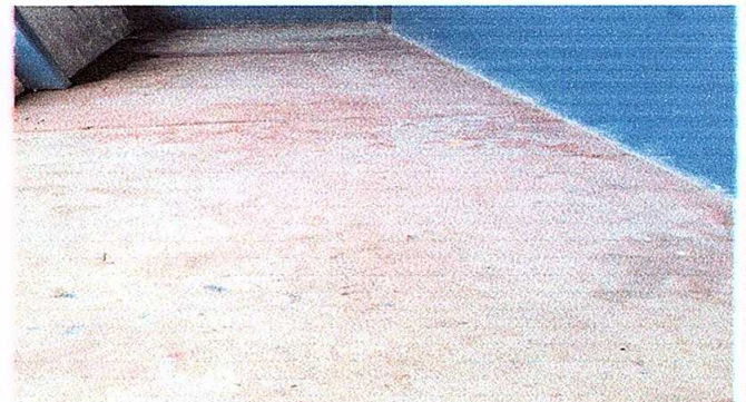
Foto 4: Reparación de piso por piso granito
