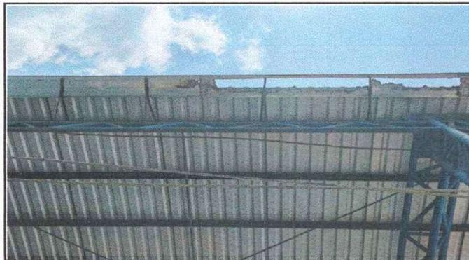
Foto 3: CANCHA : Sustitucion de canales de metal
