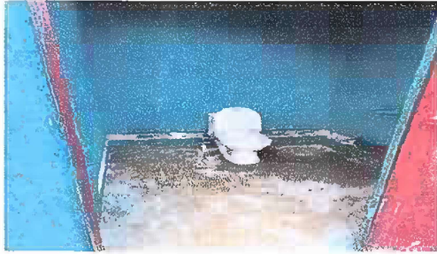
Foto 13: MODULO 3 Sustitución de Sanitario e Instalacion de accesorios
