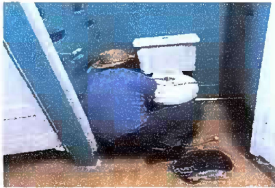
Foto 9: MODULO 2: Sustitucion de Sanitario e Instalacion de accesorios
