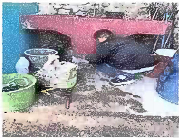
Foto 17: MODULO 3 Sustitucion e intalacion de Pila de dos lavaaderos
