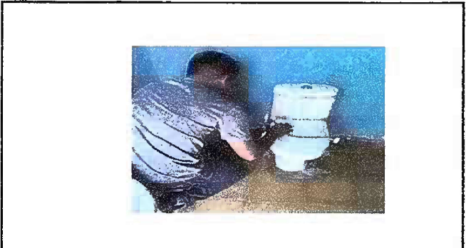
Foto3: MODULO 1: Sustitucion de inodoro e intalacion de accesorios
