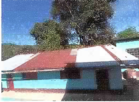
FOTO: 1 Módulo 1: Sustitución de lámina, por lámina troquelada ALUZINC cal. 26
