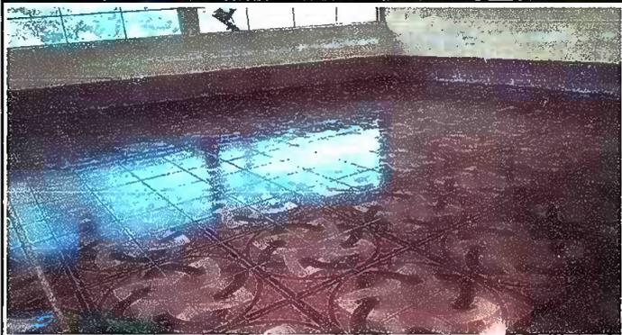
Foto 1: Modulo 2 sustitución de piso de concreto por piso ceramico
