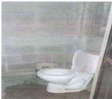
Foto 3. Módulo 1: Suministro e instalación de azulejo
