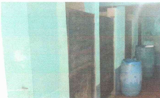
Foto 5. Módulo 1: sustitución de puertas en servicios sanitarios
