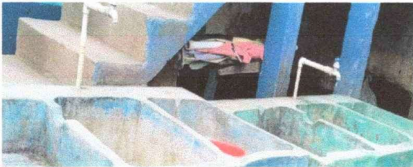
Foto 9. Módulo 2: sustitución de tubería de línea principal
