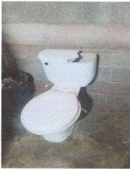
Foto 1. Módulo 1: sustitución de inodoro
