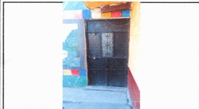
Foto 3: Módulo 2: Sustitución de puertas
