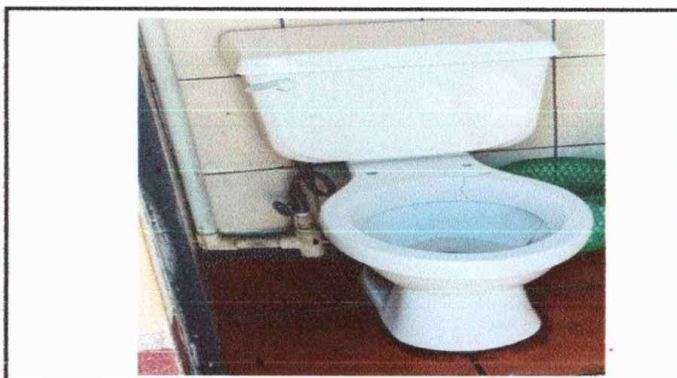
Foto 4: Módulo 3: Sustitución de inodoro
