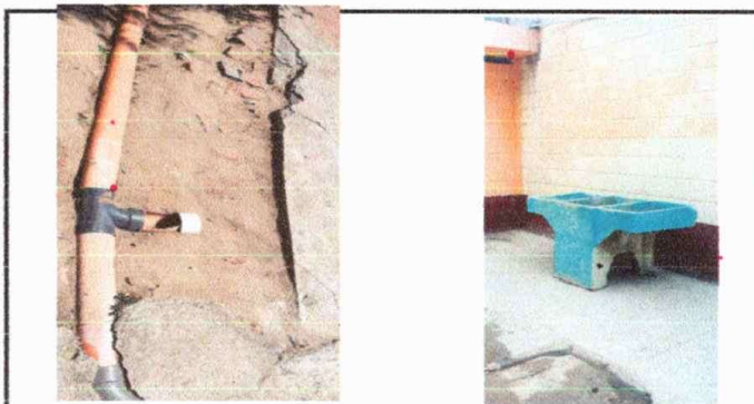
Foto 6: Módulo 4: Sustitución de tubería PVC para aguas negras y Sustitución de pila de cemento de dos lavaderos.
