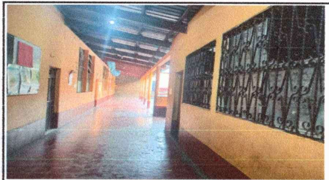
Foto 2: Módulo 2: Sustitución de estructura de metal de ventana
