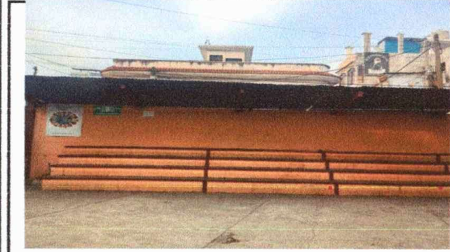
Foto 1: Módulo 1: Sustitución de lámina por lámina
