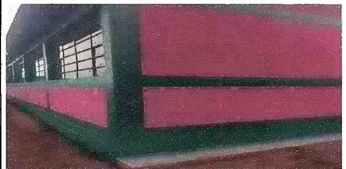
Foto 6: pintura exteriores e interiores.
