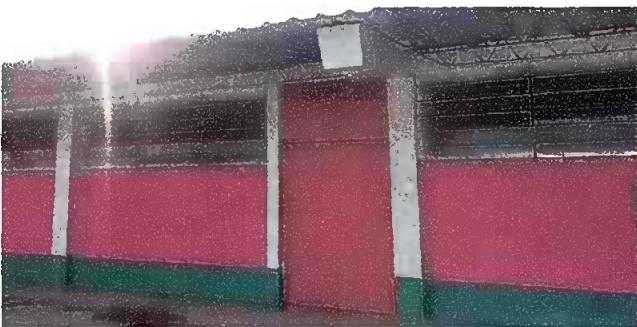
Foto 5: pintura exteriores e interiores.
