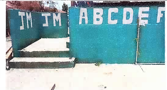
Foto 6: el avance del trabajo de la pintura.
