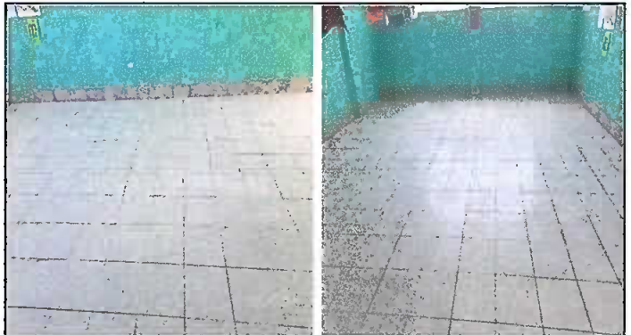
Fotografía 4. MODULO 2: Sustitución de piso cerámico
