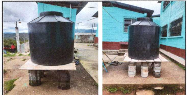
Fotografía 12. Sustitución de depósito de agua y suministro de base de concreto para tinaco.
