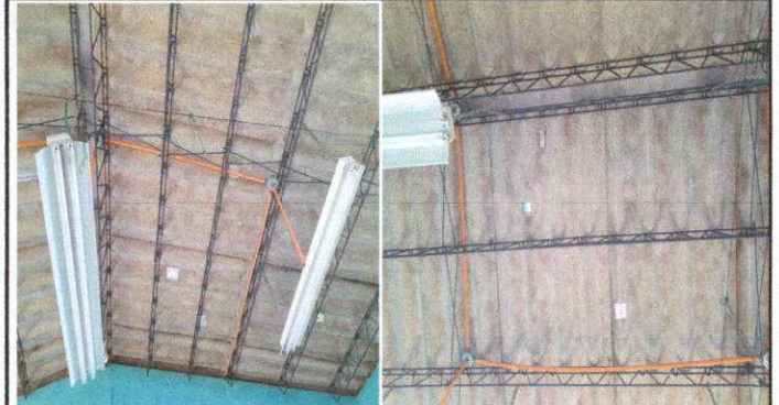
Fotografía 2. MODULO 1: Sustitucion de estructura de soporte de metal, por metal
