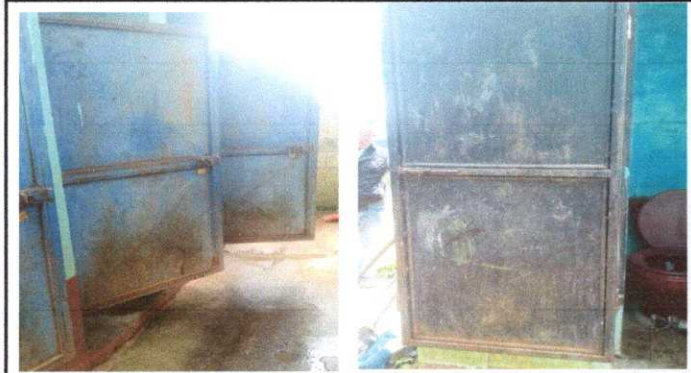
Fotografía 7. MODULO 3: Mantenimiento a estructura de puerta (pintura)
