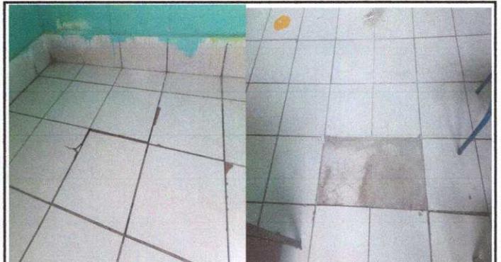
Fotografía 4. MODULO 2: Reparación de piso cerámico
