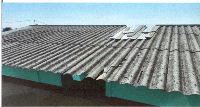
Fotografía 1. MODULO 1: Sustitucion de lámina (duralita) capote y elementos de fijación (tornillos) por lámina troquelada.
