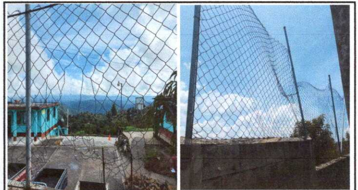
Fotografía 10. MURO PERIMETRAL: Reparación de malla galvanizada
