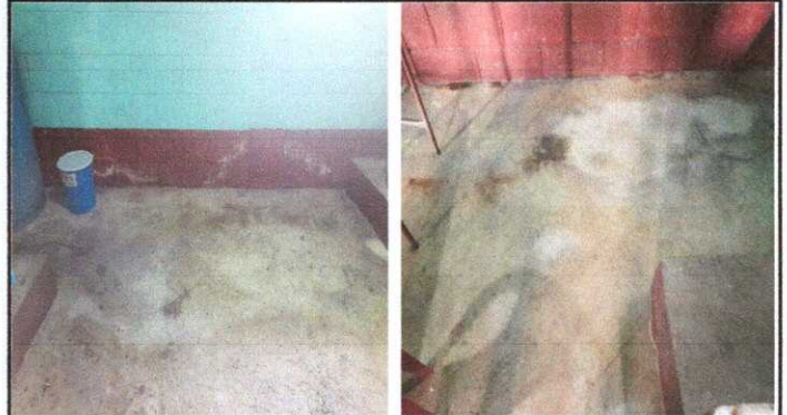
Fotografía 8. MODULO 4: Sustitución de piso de torta de concreto, por piso ceramico.
