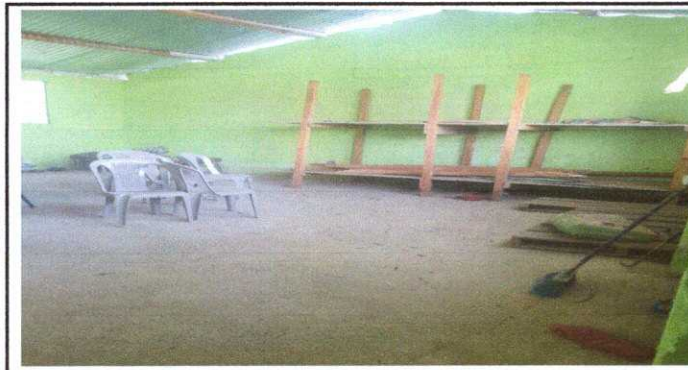
Fotografía 3. MODULO 2: Sustitución de piso de torta de concreto, por piso cerámico
