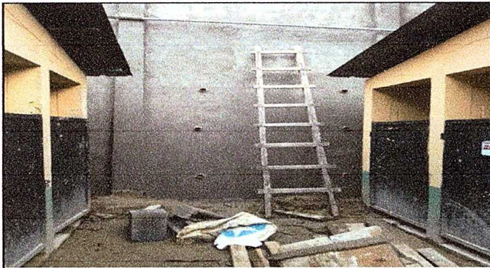
Foto 3: TERMINACIÓN DEL MURO DE CONTENCIÓN
