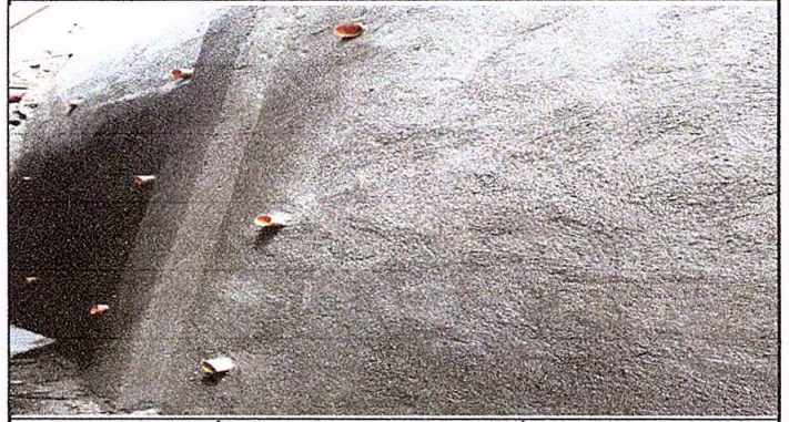
Foto 2: TERMINACIÓN DEL MURO DE CONTENCIÓN
