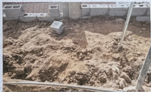
Foto 6: REPARACIÓN MURO DE CONTENCIÓN
