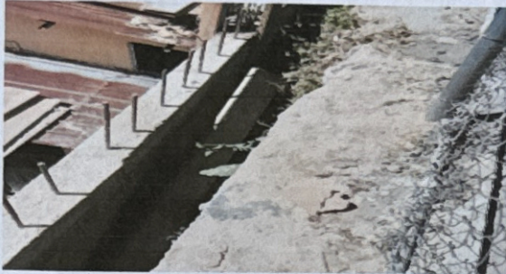
Foto 1: REPARACIÓN MURO DE CONTENCIÓN
