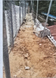
Foto 2: REPARACIÓN MURO DE CONTENCIÓN
