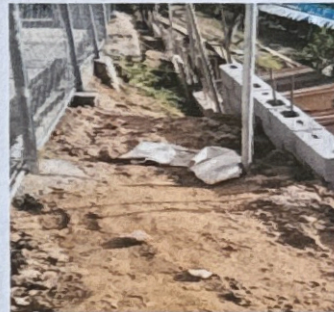
Foto 4: REPARACIÓN MURO DE CONTENCIÓN
