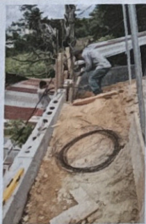
Foto 5: REPARACIÓN MURO DE CONTENCIÓN
