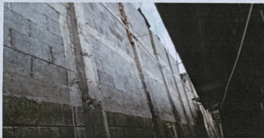
Foto 3: REPARACIÓN MURO DE CONTENCIÓN
