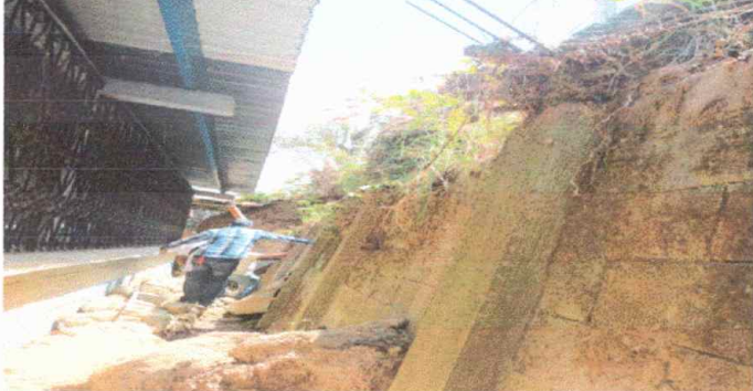
Foto 2: REPARACION DE MURO DE CONTENCIÓN
