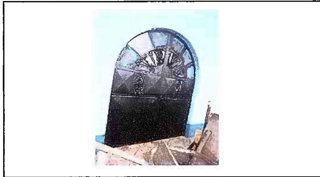
Foto 3: (MODULO II) Mantenimiento a estructuras de puertas
