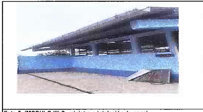
Foto 5: (MODULO III) Suministro e intalación de canal
