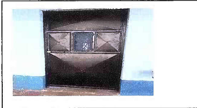
Foto 1: (MODULO I) Mantenimiento a estructuras de puertas
