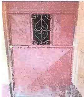
Foto 15: (MODULO V) Mantenimiento a estructuras de puertas
