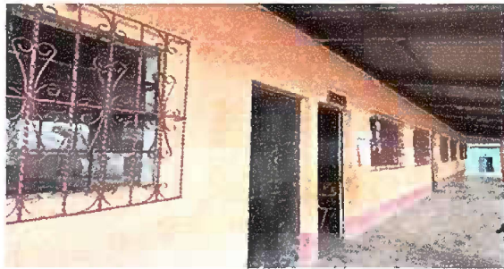
Foto 3: (MODULO II) Mantenimiento a estructuras de puertas
