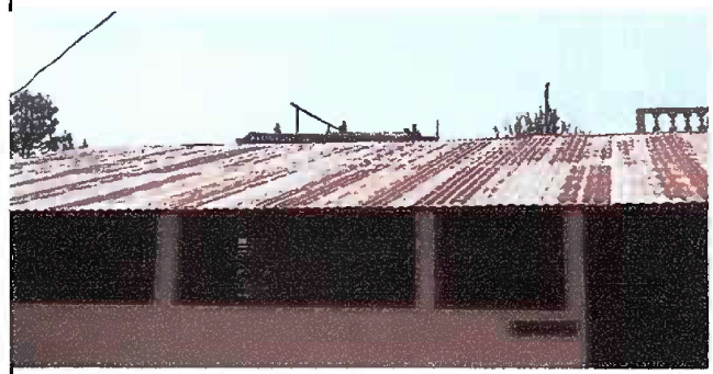
Foto 8: (MODULO III) sustitución de lámina por lámina troquelada
