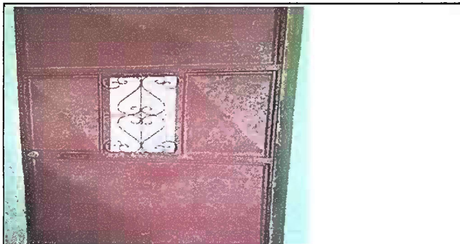
Foto 9: (MODULO IV) Mantenimiento a estructuras de puertas
