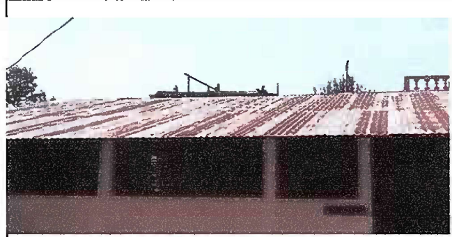
Foto 14: (MODULO V) sustitución de lámina por lámina troquelada
