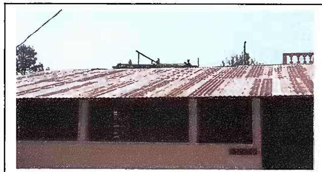
Foto 12: (MODULO IV) Sustitución de lámina por lámina troquelada
