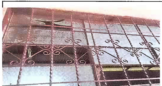
Foto 10: (MODULO IV) Sustitución de vidrios
