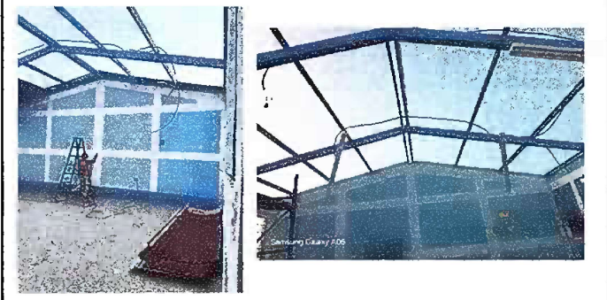
Foto No. 1 MODULOS 1 Sustitución de lámina por lamina toquelada aluzinc calibre 26 y mantenimiento a estructura de soporte metal
