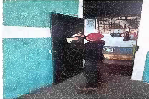
Foto No. 8 MODULO 4 Mantenimiento a estructura de puerta (aplicación de pintura)
