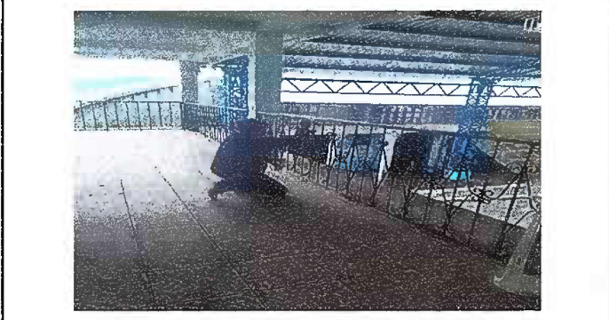
Foto No. 5 MODULO 2 Mantenimiento a baradas de metal.
