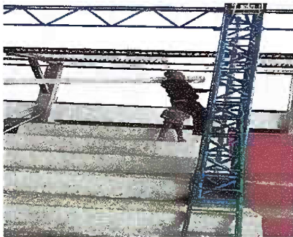
Foto No. 11 MODULO 5 Sustitución de bajada de agua pluvial de tubo PVC 3 y sustitución de canales PVC.
