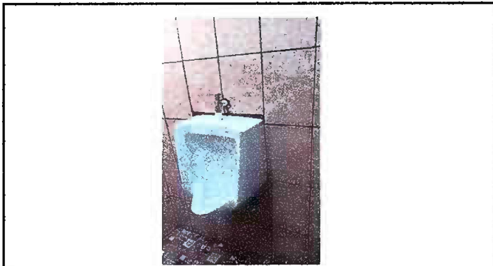
Foto 27 Módulo 6: Sustitución de mingitorio.
