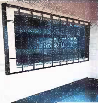
Foto 11 Módulo 2: Sustitución de balcón de metal.
