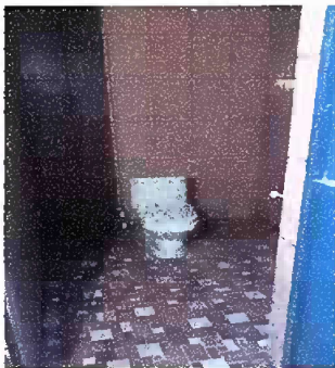
Foto 21 Módulo 5: Sustitución de inodoro.
