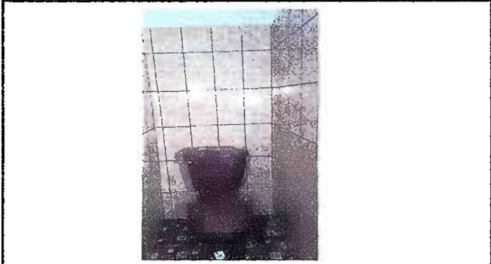
Foto 26 Módulo 6: Sustitución de inodoro.
