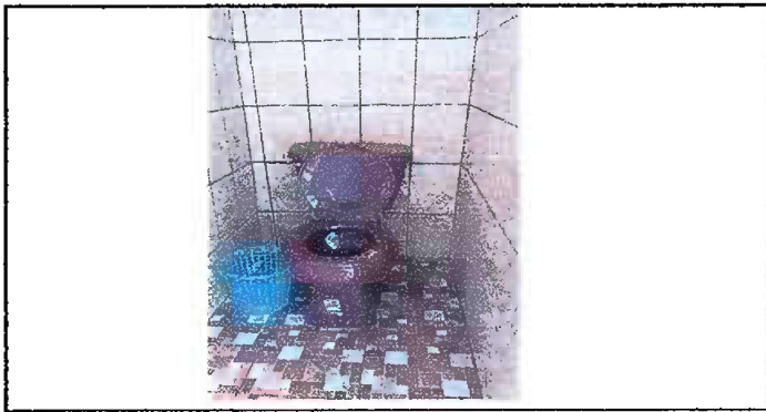
Foto 29 Módulo 6: Sustitución de azulejos.
