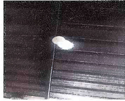
Foto 20 Módulo 4: Sustitución de plafoneras.
