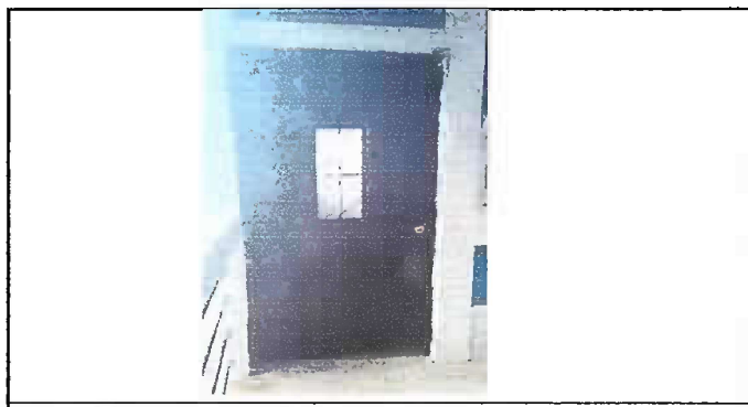
Foto 11: Modulo VI. Sustitución de puerta de aula
