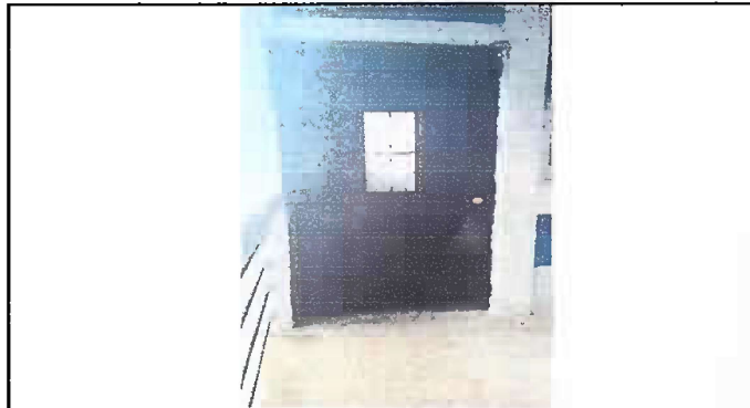
Foto 9: Modulo IV. Sustitución de puerta de Dirección
