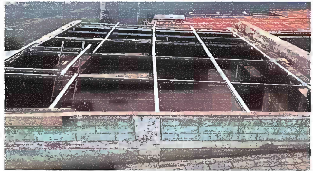
Foto 6: Módulo 2. Techo de cocina. Instalación completa de soporte de láminas
