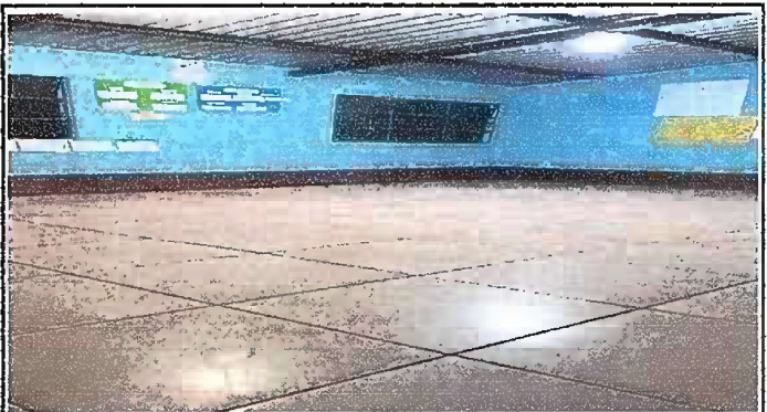
Foto 4: MODULO 1: adentro del aula de 4to. A. sustitucion de piso de granito.
