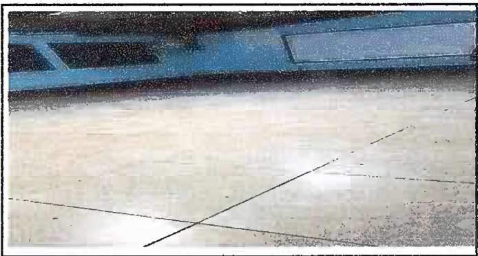
Foto 5: MODULO 2: adentro del aula 5to. B. sustitucion de piso de granito.
