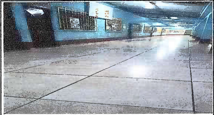
Foto 1: MODULO 1: corredor de las 6 aulas lado izquierdo, sustitucion de piso de granito
