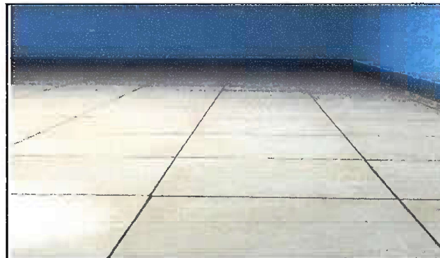
Foto 6: sustitucion de torta de piso de concreto por piso ceramicomo modulo 4
