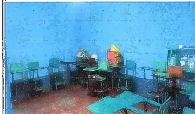
Foto 4: pintura de interiores y exteriores modulo 2
