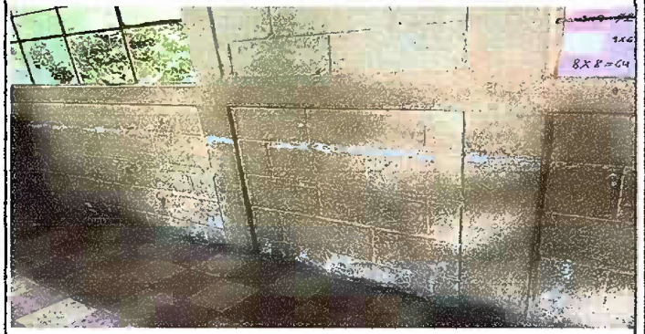
Foto 2: pintura de interiores modulo 1
