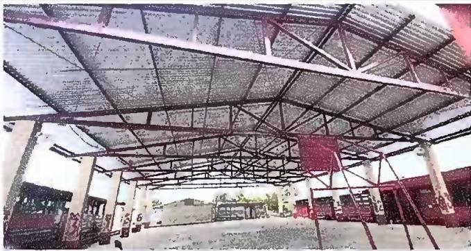
Foto1: Módulo 1. Finalización de mantenimiento a estructura de soporte de metal.
