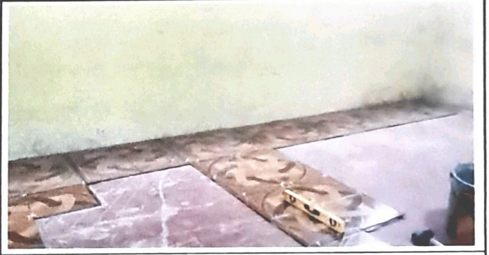
Foto 4: Módulo 2. Colocación de piso cerámico.
