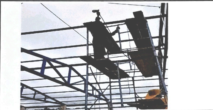
Foto 3: Módulo 1. Mantenimiento a estructura de soporte de metal
