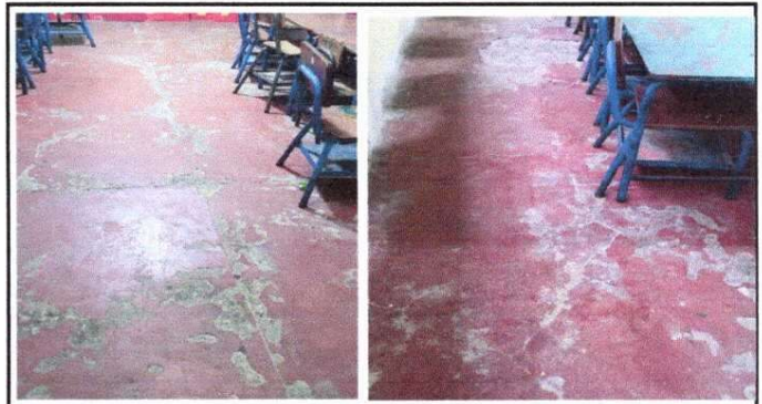
Foto 4: Módulo 2. sustitución de piso de torta de concreto por piso cerámico.
