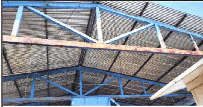
Foto1: Módulo 1. Mantenimiento a estructura de soporte de metal.
