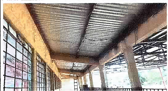
Foto 2: Módulo 1: Avance de Mantenimiento a estructura de metal
