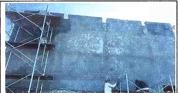
Foto 4: Módulo 2 avance de cernido en muro
