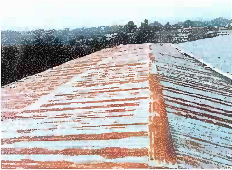
Foto 1, módulo 1: Sustitución de tornillo, capote y lámina, por lámina troquelada aluzinc calibre 26
