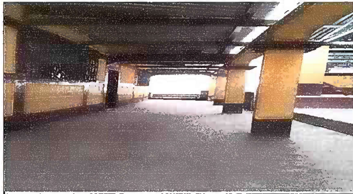
Foto 3: SUSTITUCION DE ESTRUCTURA DE SOPORTE DE MADERA POR METAL EN MODULO 2
