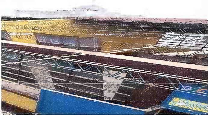
Foto 1: SUSTITUCION DE LAMINA POR LAMINA TROQUELADA EN MODULOS 1.
