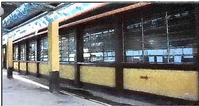
Foto 5: SUMINISTRO E INSTALCIÓN DE BALCONES DE METAL EN MODULO 4
