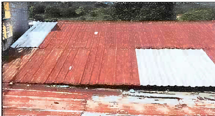
Foto 6: SUSTITUCION DE LAMINA POR LAMINA TROQUELADA EN MODULO 6
