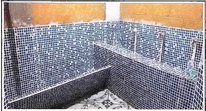
Foto 2, Módulo 1: Suministro e instalación de azulejos.
