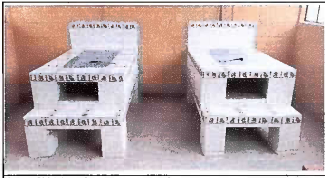
Foto 5, Módulo 2: Sustitución de estufa rural y sustitución de azulejos
