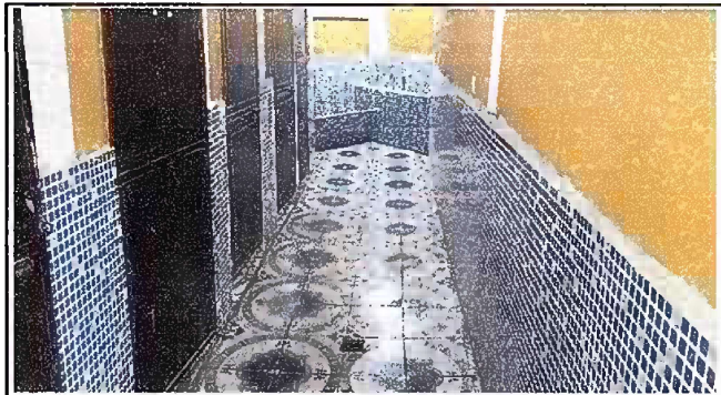
Foto 3, Módulo 1: Sustitución de piso de concreto por piso ceramico.
