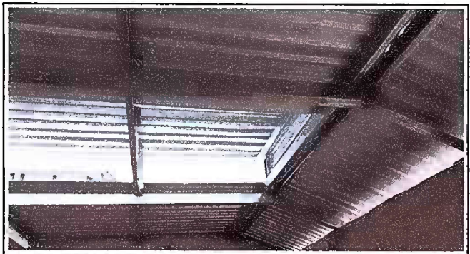
Foto 4, Módulo 2: Sustitución de lámina, por lámina troquelada aluzinc calibre 26 y Sustitución de estructura de soporte de madera, por metal.
