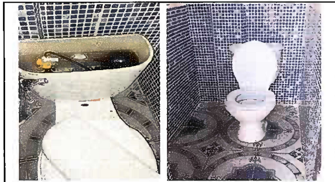
Foto 1, Módulo 1: sustitución de accesorios inodoro (contra llave, tubo de abasto y tanque)
