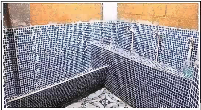
Foto 2, Módulo 1: Suministro e instalación de azulejos.
