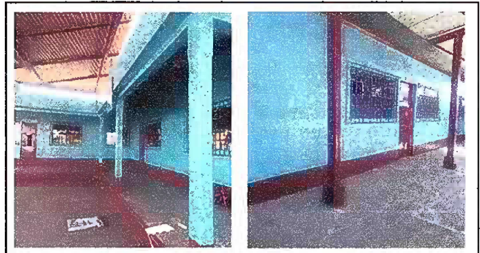
Foto 10: Pintura en muros interior y exterior.
