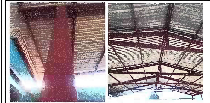
Foto 5: Módulo 1 Mantenimiento de estructura de soporte de metal
