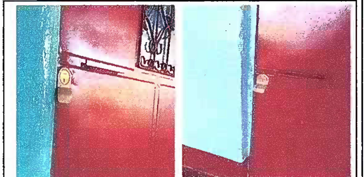
Foto 6: Módulo 2 Sustitución de chapas en puerta de metal.
