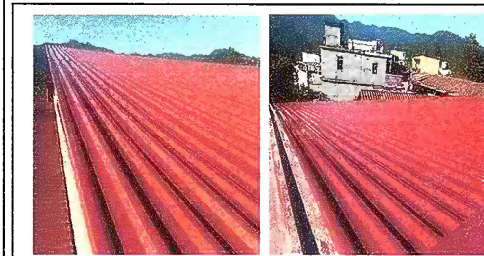
Foto1: Módulo 1 Sustitución de láminas troquelada calibre 26.
