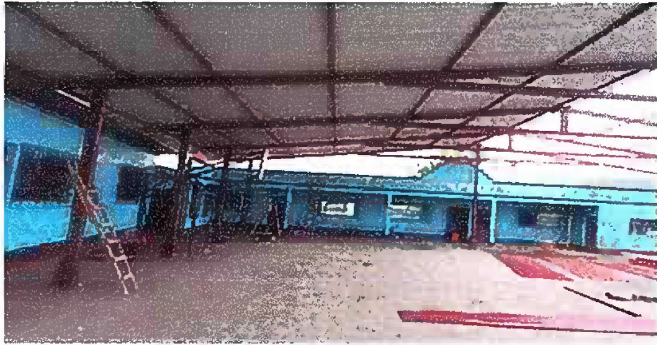
Foto1: Módulo 1 Sustitución de láminas troquelada calibre 26.
