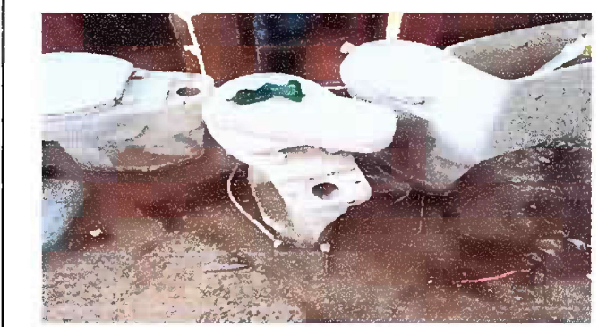
Foto 8: Módulo 4. Sustitución de inodoros
