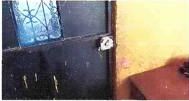
Foto7: Módulo 3. Sustitución de chapas en puertas de metal
