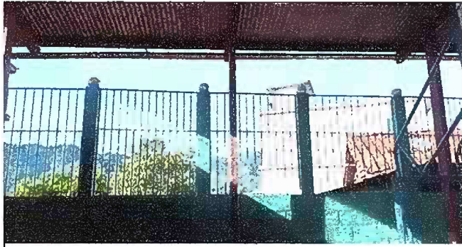
Foto : 9. Muro perimetral. Reparación de banda perimetral.
