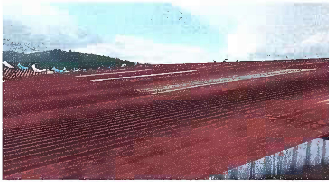
Foto 1: Módulo 1. Sustitución de lámina troquelada, calibre 26.
