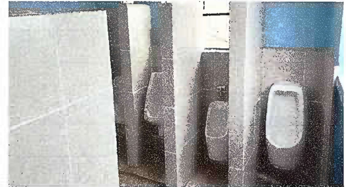
Foto 10: Sustitución de migitorios por losa
