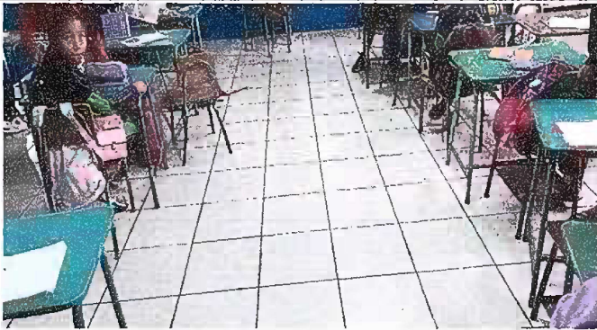
Foto7: Sustitucion de piso de torta de concreto por cerámico aula numero 3
