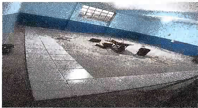
Foto 7: Sustrucción de piso de torta de concreto por cerámico aula numero 3
