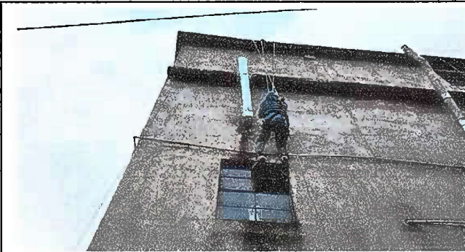
Foto 3: Sustitución de chimineas de cocina numero 2
