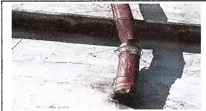
Foto 3: Sustitución de chimineas de cocina numero 2
