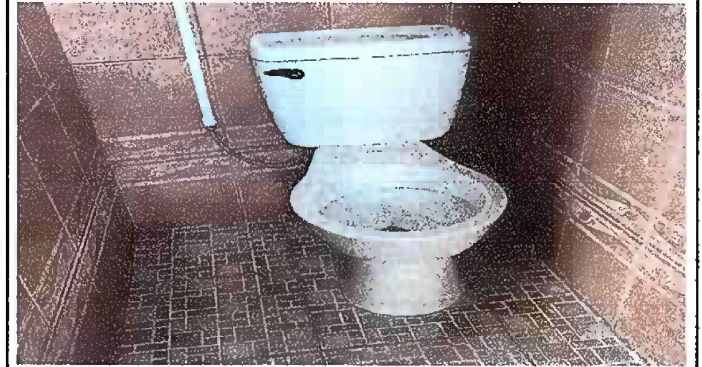
Foto 12: Sustitución de taza de baño
