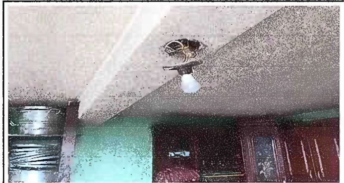
Foto 4: Sustitución de cableado de cocina
