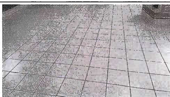
Foto 6: Sustitución de piso de cemento líquido a piso ceramico
