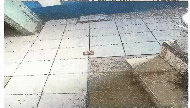
Foto 4: Sustitución de piso de cemento líquido a piso cerámico
