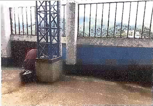
Foto 3: Aplicación de repello de muro de contension
