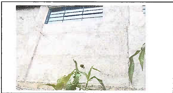
Foto 6: Repello de cocina
