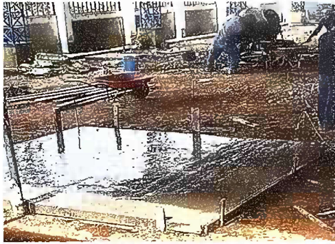
Foto 1: Reparación de plancha de concreto de patio
