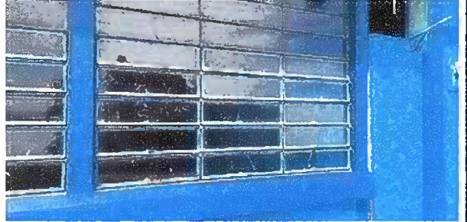
Foto 2: Modulo 1. Sustitución de vidrios.
