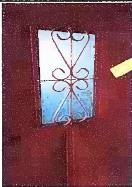
Foto 9: Modulo 3 sustiticion de vidrio
