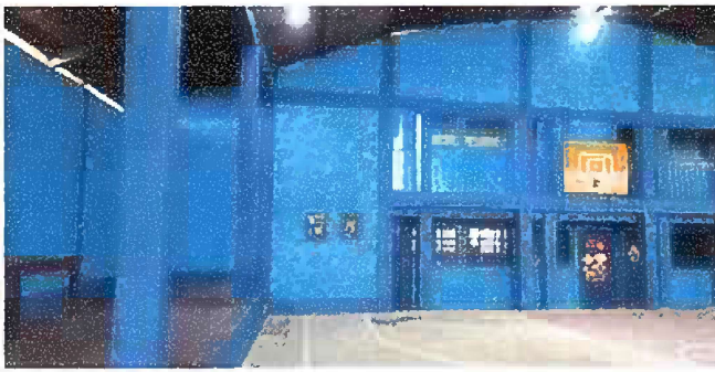
Foto 23: modulo 6 pintura general en muros exteriores einteriores.
