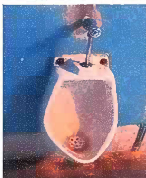
Foto 15: Modulo 5 sustitucion de llave de mingitorio.
