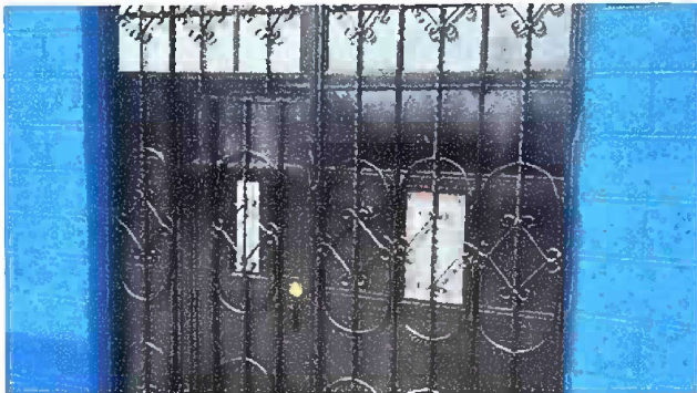
Foto 21: Modulo 6 Sustitución de Chapa
