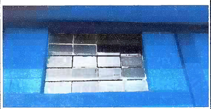
Foto 22: Modulo 6 sustitución de vidrio
