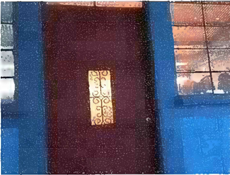
Foto 7: Modulo 2 Sustitución de vidrios
