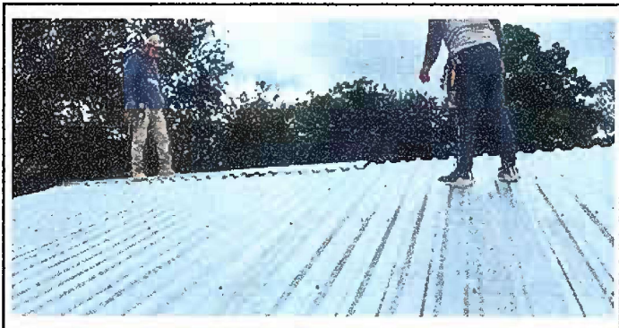
Foto 4: modulo 1 Sustitución de capote de lámina para lamina troquelada.
