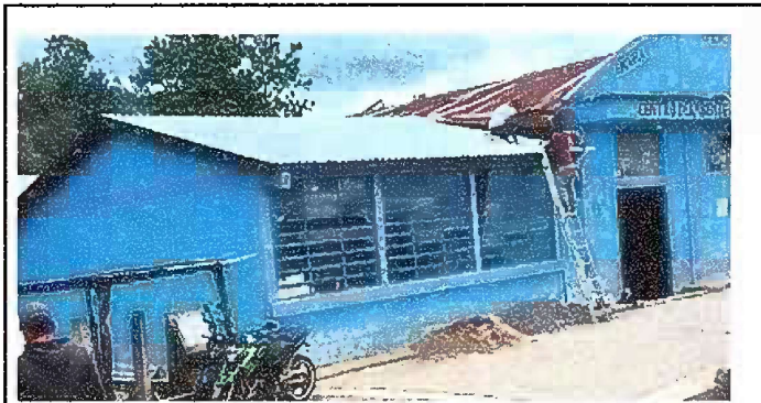
Foto 3: Modulo 1 Sustitución de elementos de fijación (tornillos)
