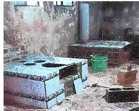
Foto 10: Modulo 3 Sustitución de estufa rural (completa) incluye chimenea y plancha de metal
