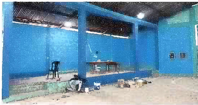
Foto 23: modulo 6 pintura general en muros exteriores e interiores.
