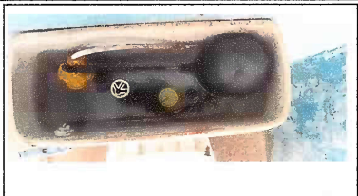
Foto13: Modulo 5. Sustitución de accesorios de inodoro (contra llave, tubo de abasto y tanque)
