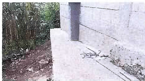
Foto 16: MÓDULO 2 Reparación de banqueta de concreto
