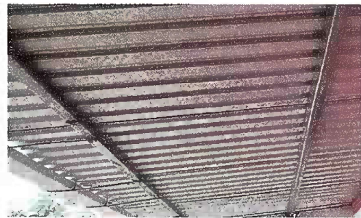
Foto 10: MÓDULO 2 Sustrucción de estructura de soporte de madera por metal en estado
