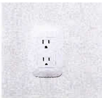
Foto 11: MÓDULO 2 Sustrucción de toma corrientes dobles
