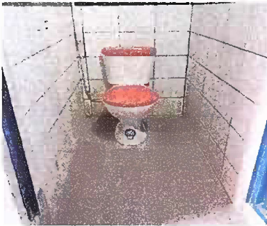
Foto 3: MODULO 1 Sustitución de piso de baños en mal estado
