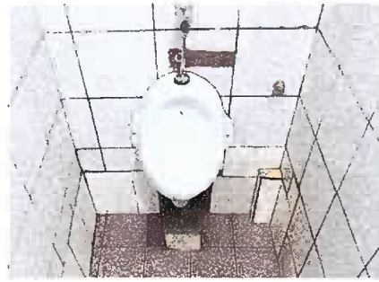
Foto 2: MODULO 1. Sustitución Mingitorio en mal estado
