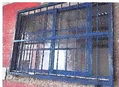
Foto 18: MÓDULO 2 Sustitución de vidrios
