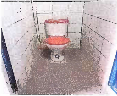
Foto1: MODULO 1. Sustitución de inodoros en mal estado
