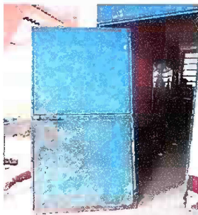
Foto 23: MÓDULO 3 Sustitución de puertas de metal
