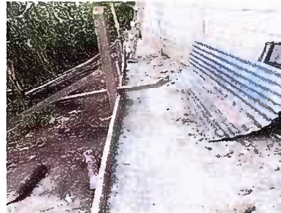
Foto 16: MÓDULO 2 Reparacion de banqueta de concreto
