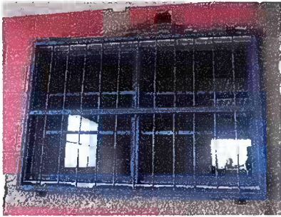
Foto 19: MÓDULO 2 Suministro e instalacion de balcon de metal
