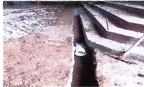
Foto 22: MÓDULO 3 Sustitución de tubería pvc, línea principal agua negras
