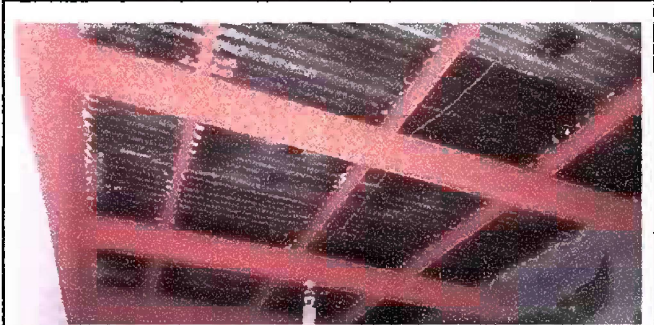
Foto 25: MÓDULO 4 - Techo Escenario. Sustitución de lámina, por lamina troquelada aluzinc
