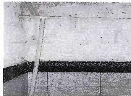
Foto 6: MODULO 1 Sustitución tubería de agua línea agua
