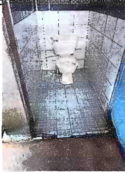
Foto1: MODULO 1 . Sustitución de inodoros en mal estado
