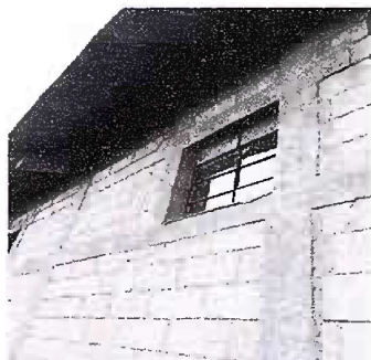
Foto 17: MÓDULO 2 Sustitución de estructura de metal de ventana
