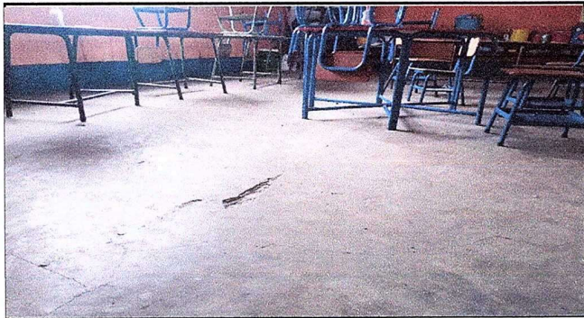
Foto 1: Colocación de piso ceramico.
