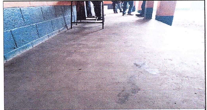
Foto 4: Colocación de piso ceramico.
