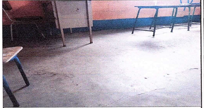
Foto 2: Colocación de piso ceramico.
