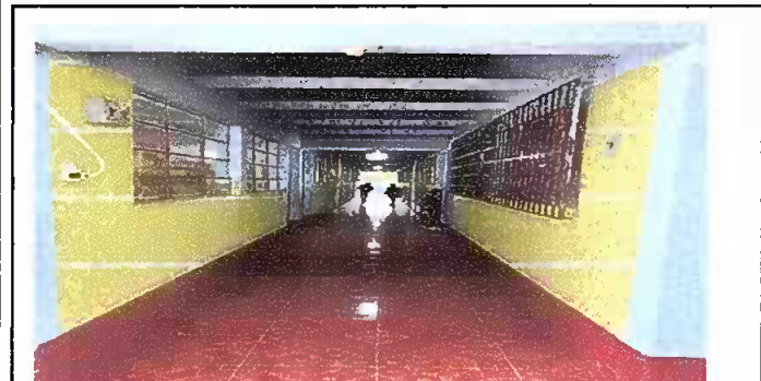
Foto 3: culminación de sustitución de piso de torta de concreto por piso ceramico.
